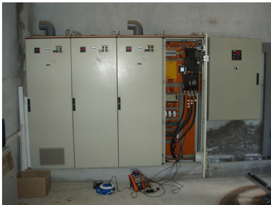
Ilustración 3: Cuadros de control de las bombas
