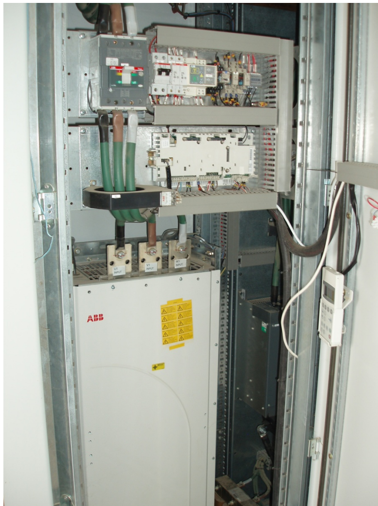
Ilustración 8: Variador de frecuencia
